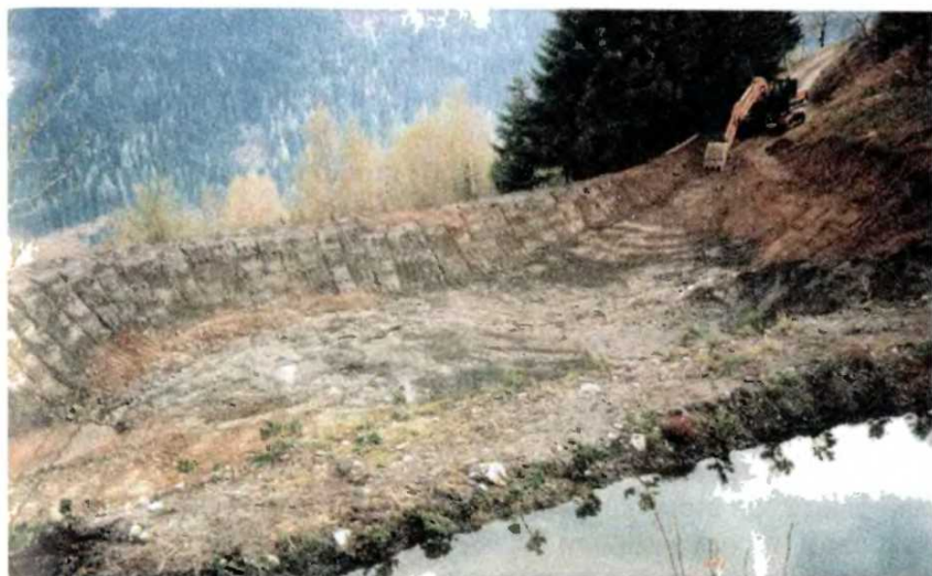
Закончено строительство пруда в Крамтерхофе.
