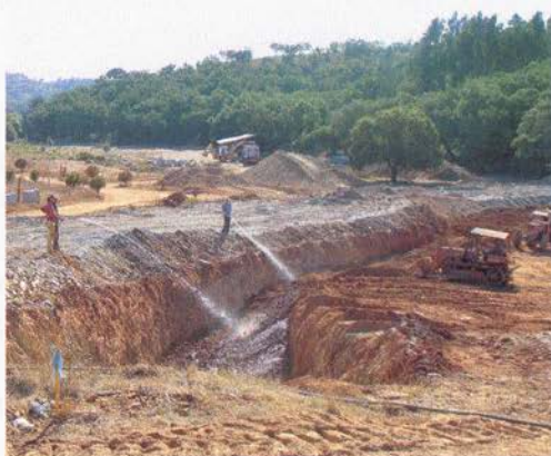
Слои изоляционного барьера увлажняются, утрамбовываются и укатываются
