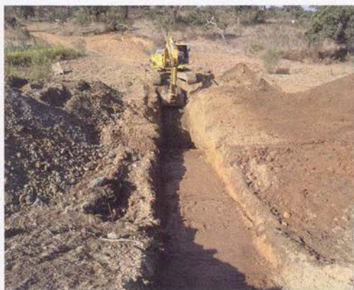
Траншея заполняется мелкозернистым почвенным материалом
