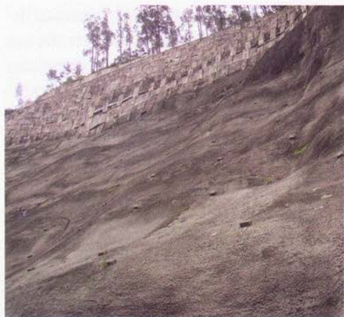
Абсолютно неправильное решение: за счет бетонирования склонов проблема только усугубляется
