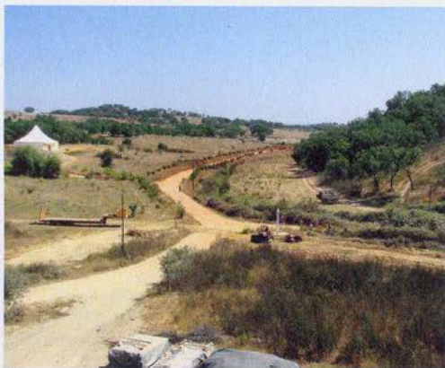
До строительства озера
