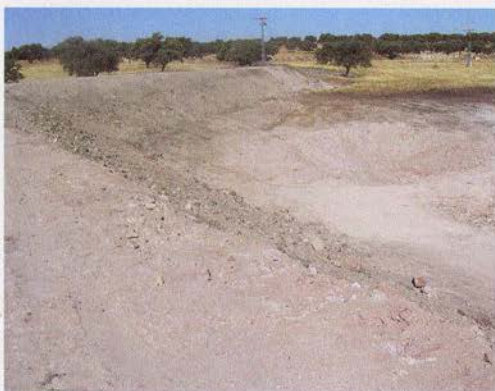
Строительство водоема природного типа для накопления воды
