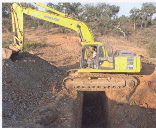
Сначала выкапывается траншея для изоляционного барьера
