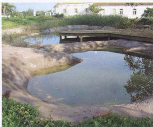
Бетонирование пруда — это всегда неверный путь. Через некоторое время вода начинает портиться
