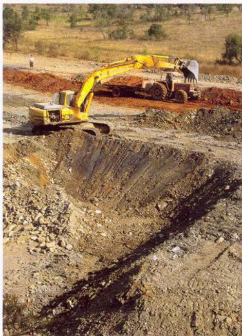
Почвенный материал для изоляционного барьера берем из будущей глубоководной зоны озера
