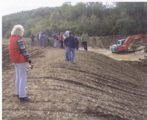
Поверх изоляционного барьера отсыпается и утрамбовывается грунт, наклон склона — примерно 45°
