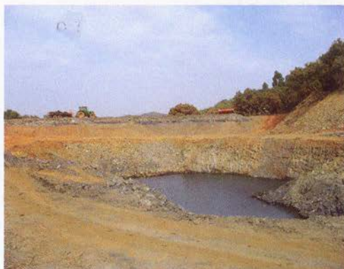
Глубоководная зона наполняется уже за счет инфильтрационной воды. Эта дамба одновременно служит дорогой
