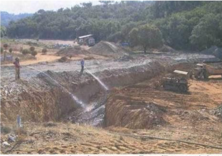
Строительство глубоководной зоны озера в Тамере (Португалия), где она 12,5 м глубиной
