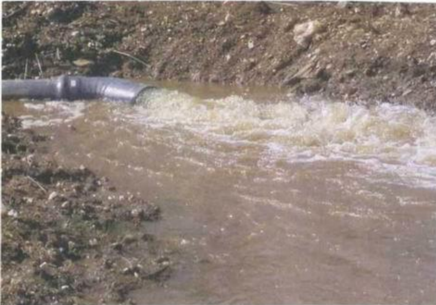
Трубчатый водослив "монах" в действии
