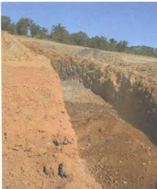
Строительство водного ландшафта: для дамбы роется траншея 3-4 м глубиной, которую заполняют глиной и уплотняют. Это глиняное ядро, выложенное слоями, в итоге должно превысить высоту желаемой водной поверхности на несколько метров
