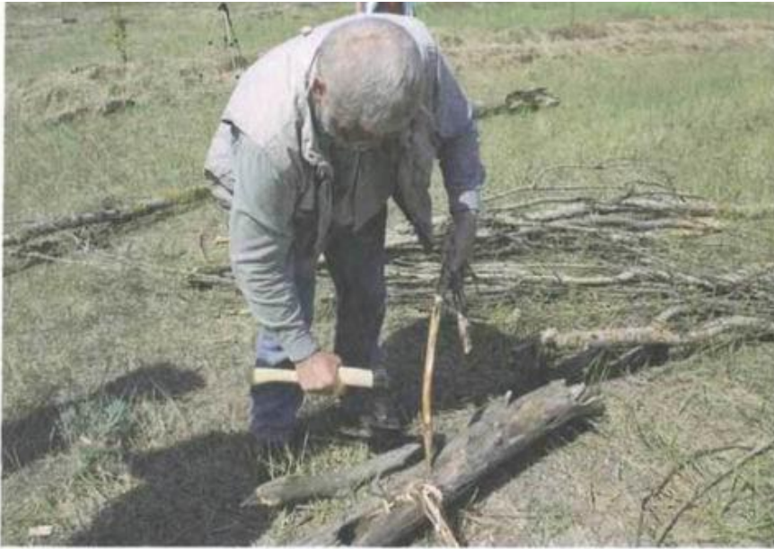
Так производят деревянные гвозди, чтобы закрепить склоны
