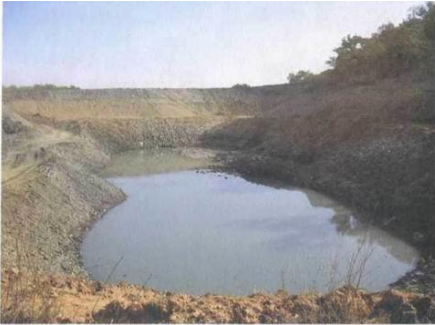
Строительство глубоководной зоны озера в Тамере (Португалия), где она 12,5 м глубиной
