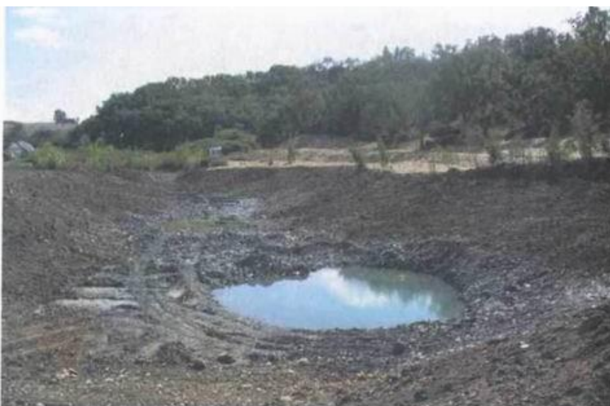
Озеро в долине в процессе сооружения
