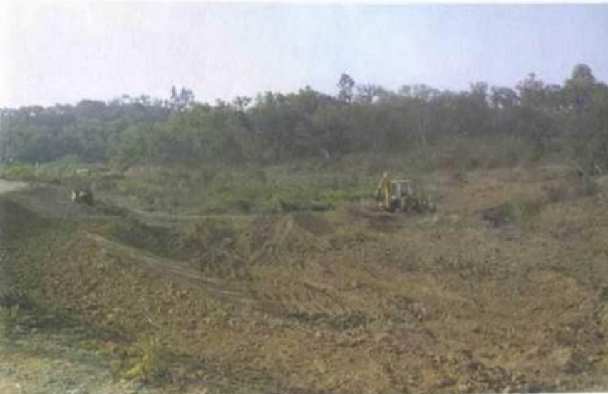
Озеро в долине в процессе сооружения
