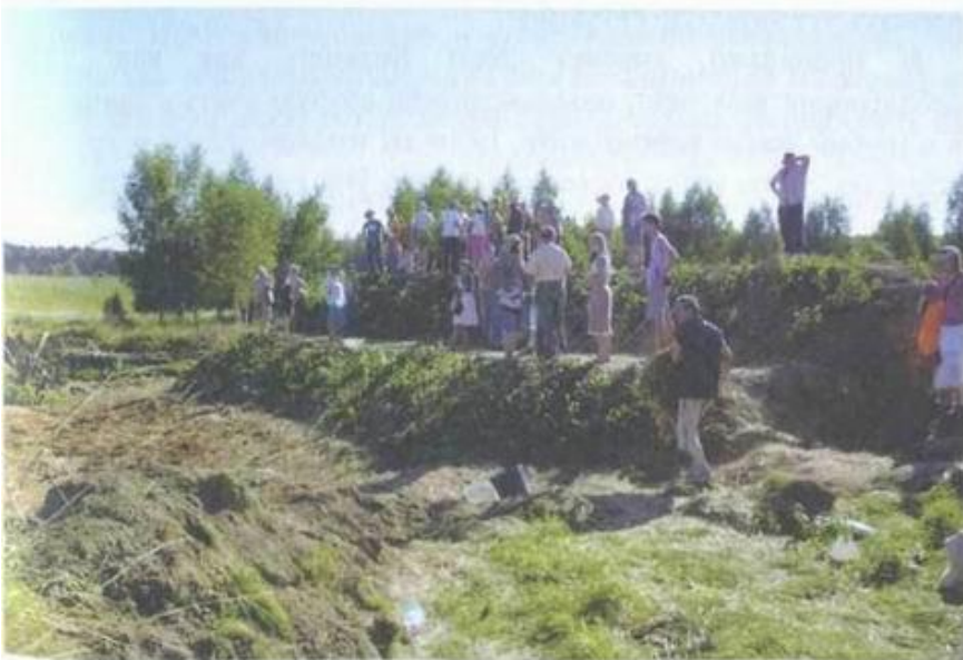
Учебная группа при строительстве кратерного сада
