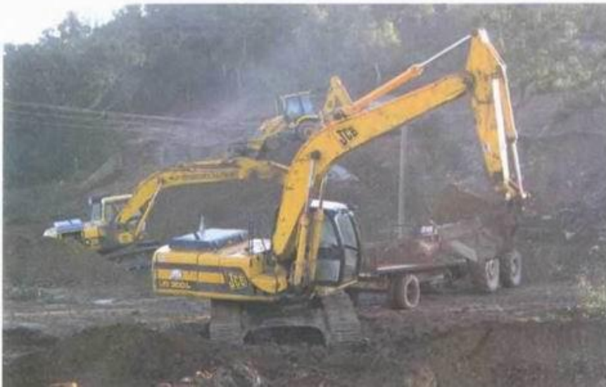
Строительство глубоководной зоны озера в Тамере (Португалия), где она 12,5 м глубиной
